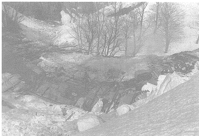
雪崩で崩壊した仮設建物（4月上旬）
