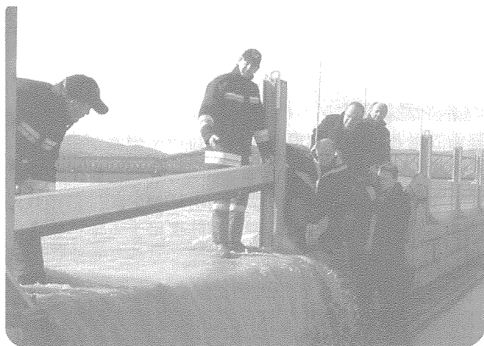
写真-2 可搬式の特種堤防、ドナウ川クレムスでの例（パッサウ市役所提供）
