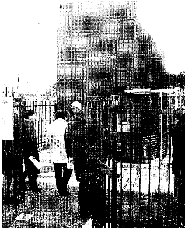
写真5 茨島跨線橋のヒートポンプ機器の見学
