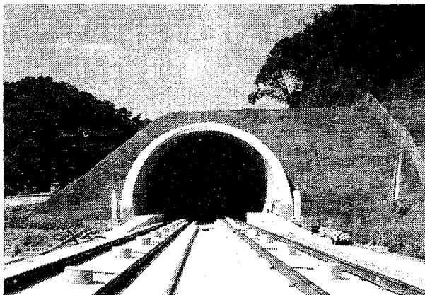
写真-11 トンネル完成 (坑口)
