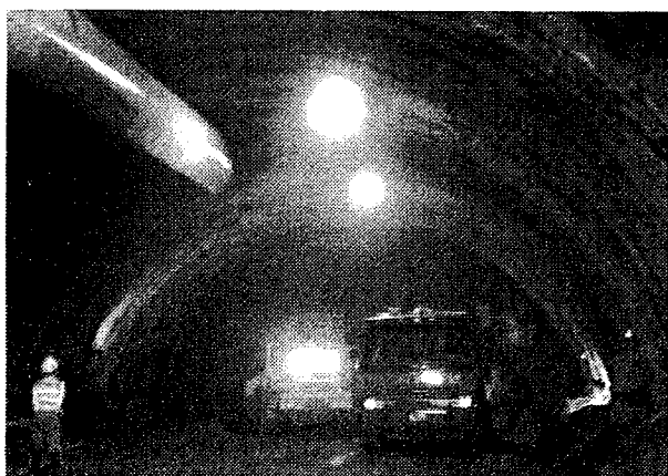
写真-9 トンネル掘削状況（上半）
