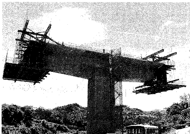
写真-5 FCM施工状況
