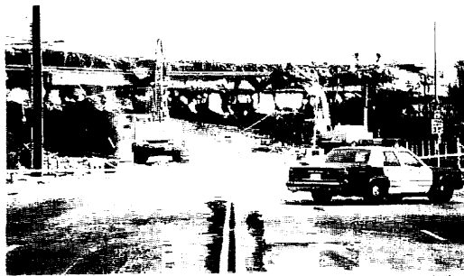
フリーウェイの落橋部の撤去作業(118号、サンフェルナンドミッション地区)
