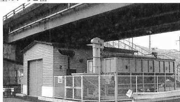
図6 ペレットボイラーを導入した村山市楯岡陸橋のロードヒーティング
