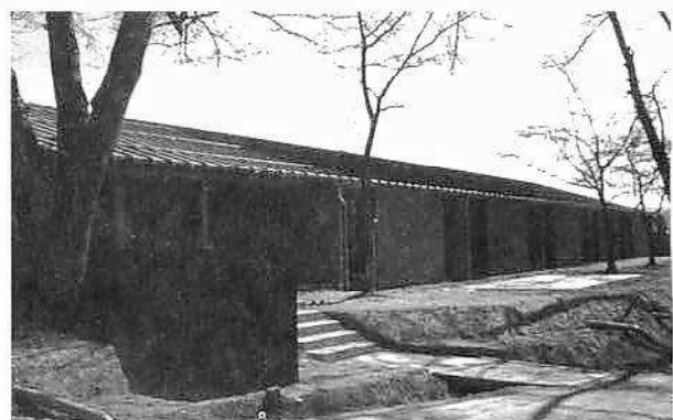
図4 ペレットボイラーを導入した村山市真下慶治記念美術館
