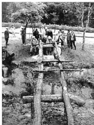
箴橋の橋桁の部分
