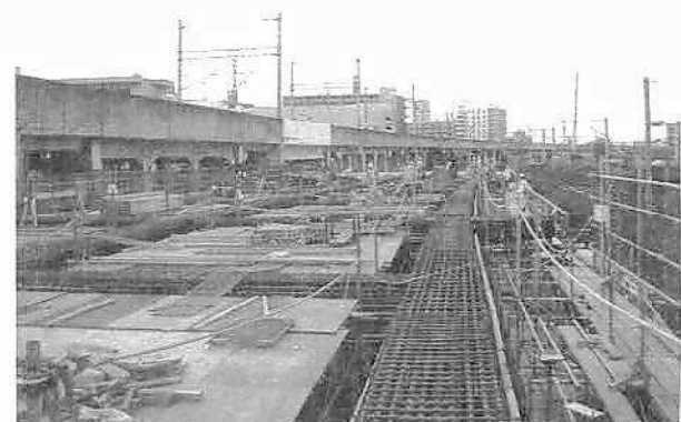
図4 新高架橋スラブの鉄筋組立状況
