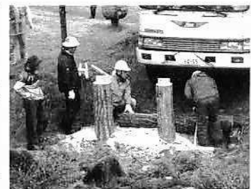
箴橋の刎部分をつくる
