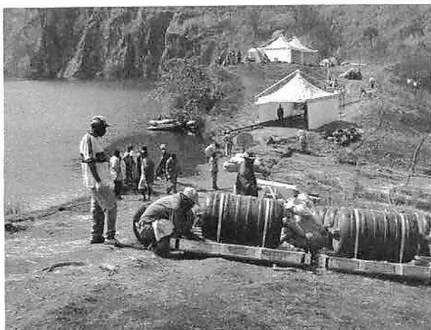
写真-3 ニオス湖岸でのフロート取り付け作業
