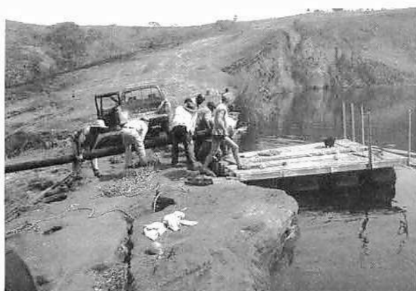
写真-4 完成したパイプを筏に取り付ける
