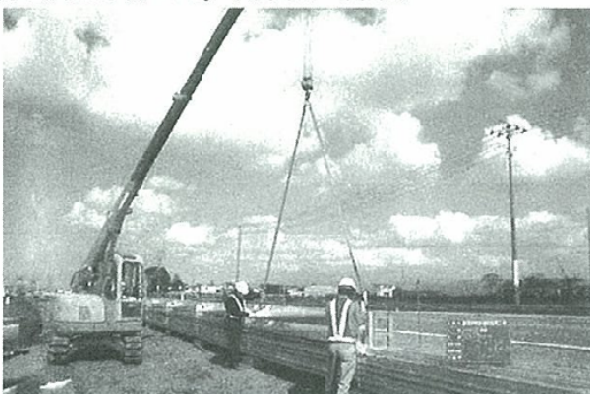
写真5 試行現場での施工状況
