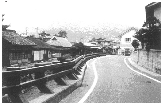
写真-22 岡山県「高梁市小高下谷川のガードレール
