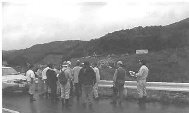
写真 1. 地すべり対策現場
