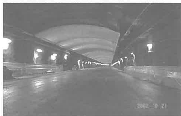
写真 1. 完成直前のストックホルム南環状道路トンネルクラウン部への風圧防止としてプレキャスト板が取り付けられている
