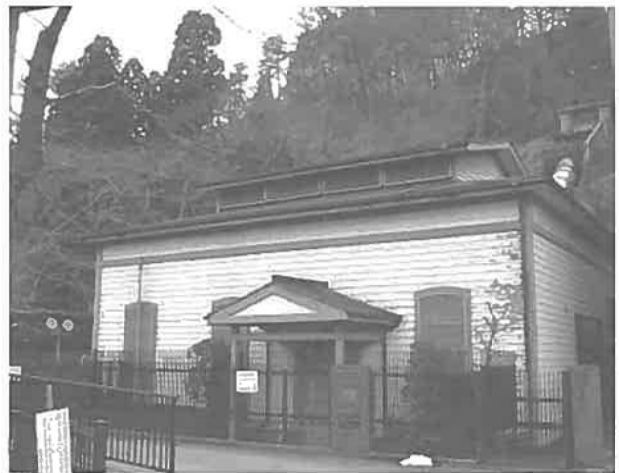
写真 1. 発電機室外観
