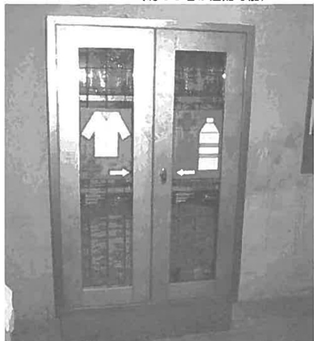
写真 3. 避難所内の救助ロッカー (耐火服、飲料水を収納)
