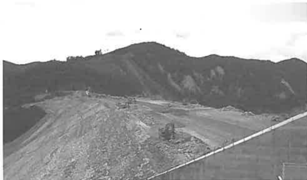
写真 1. 胆沢ダム堤体の施工状況
