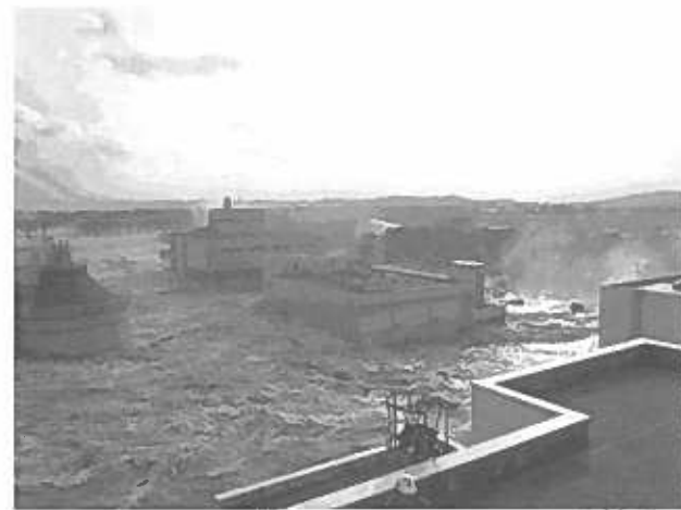
写真 1. 処理場水没状況
