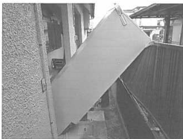
写真 2. エコキュート・タンクの転倒 4)
