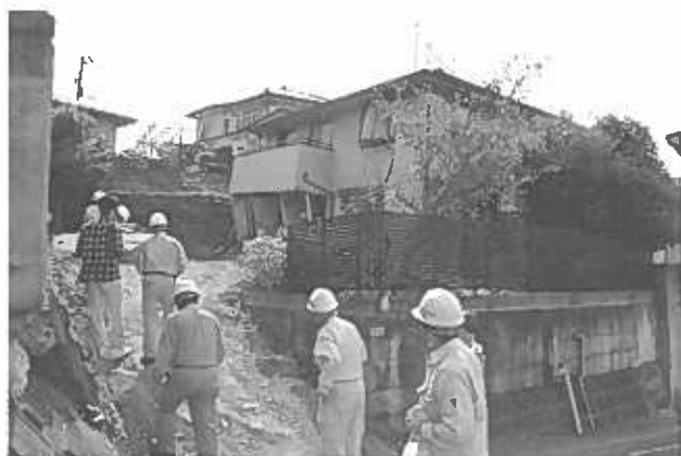
写真1. 折立団地の宅地被害
