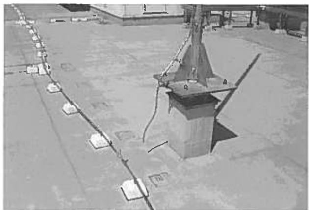
写真10. 避雷導体のせん断と移動
