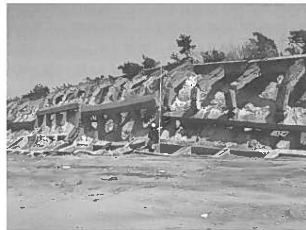
図1. 津波による海岸堤防の倒壊(宮城県山元町)
