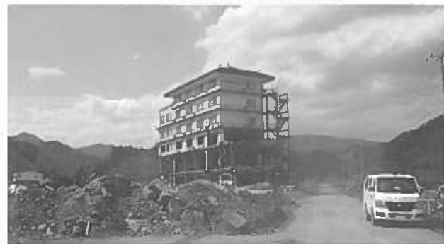
写真 5. 3階まで浸水した観光ホテル
