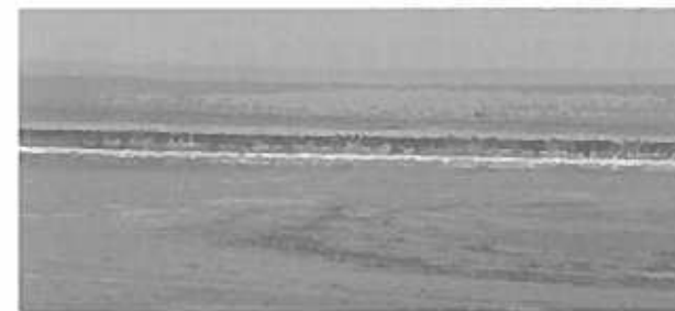
図 9 16:35北防越流でナイヤガラの滝状態
