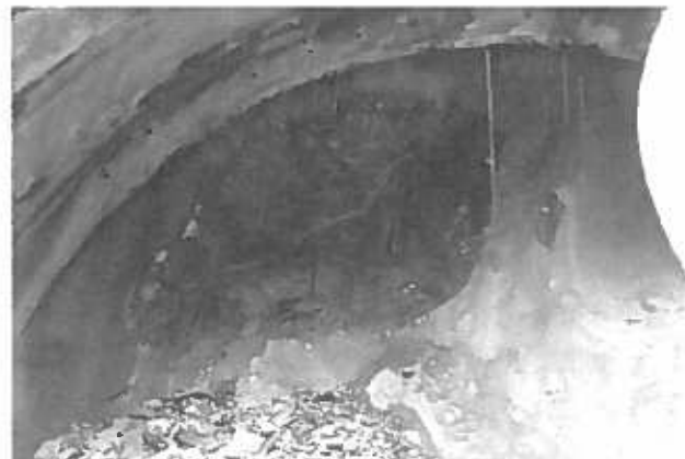
写真2. 切羽の状況 （剥離しやすい褐色の地山；写真中央上）
