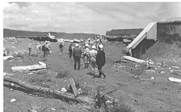
写真1. 破壊された防潮堤（野田村）
