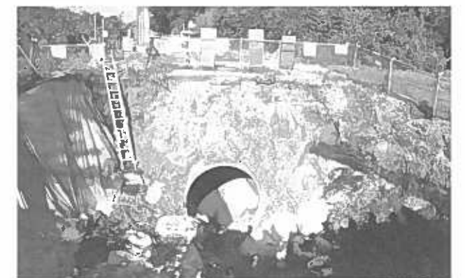
写真6. パイプラインの開削状況
