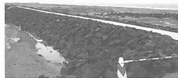
写真4. 応急仮堤防の施工状況
