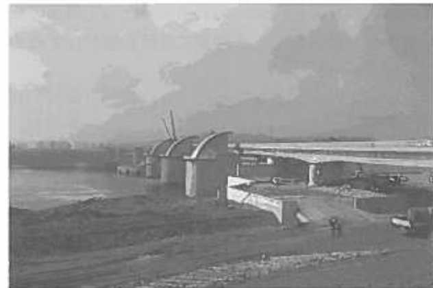
写真6. 取水・発電大堰の工事状況(全景)
