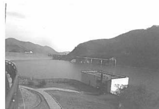
写真 1. 寒河江ダム外観
