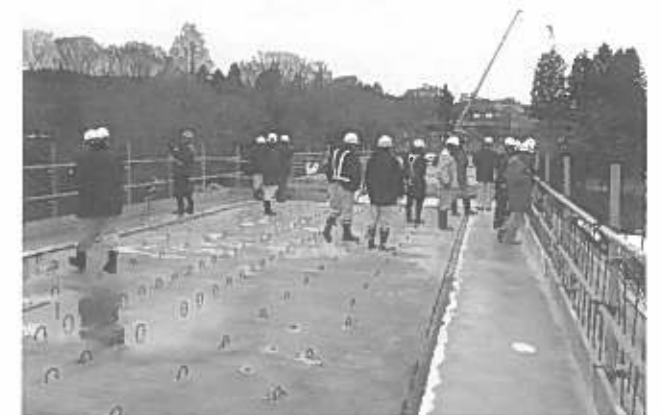
写真2. 広瀬川橋梁工区
