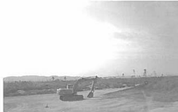
写真 5. 海岸堤防基盤面の岩ずり、フィルターの数均し
