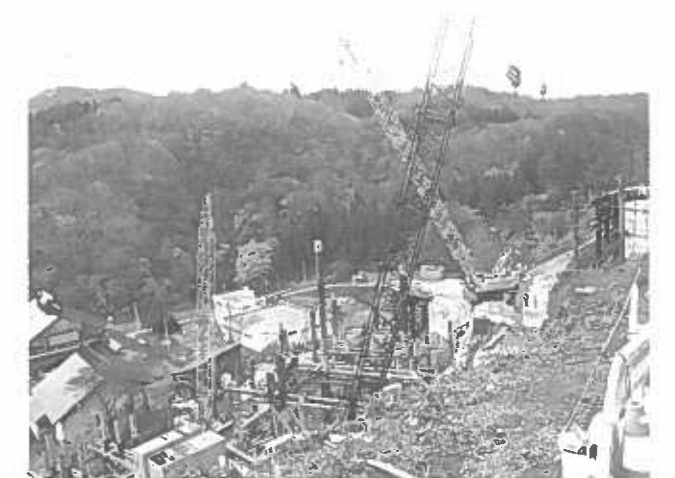
写真5. 急ピッチで進む復旧工事
