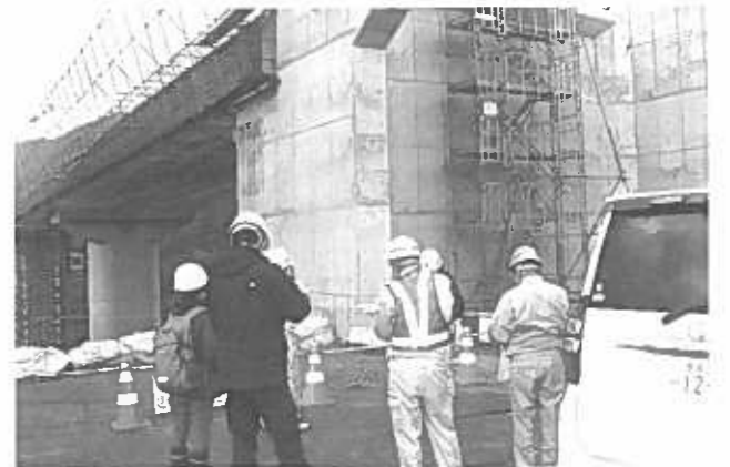
写真 1. 鱒沢地区橋梁上部工。3 次元 CAD を利用したシステムにより出来形精度の向上を図っている。
