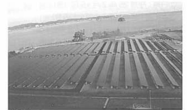
写真2. 仙台太陽光発電所外観
