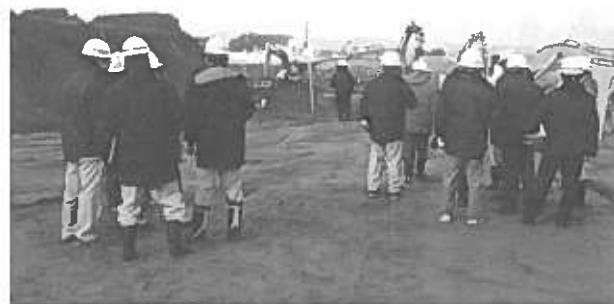
写真1. 堤防復旧盛土の状況
