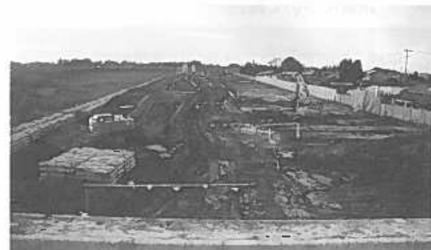
写真4. 地盤改良及び改良盛土状況
