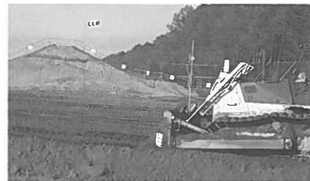
写真3. サンドマット工法の状況
