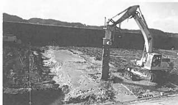
写真2. パワーブレンダー工法による地盤改良
