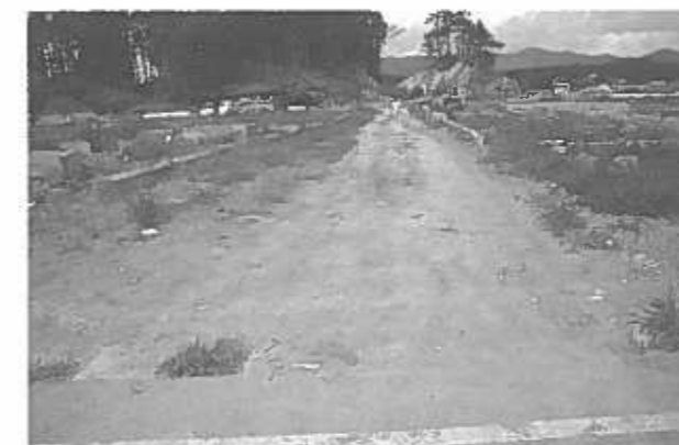
写真 8. 原形復旧として扱われた市道 (写真中央が市道)
