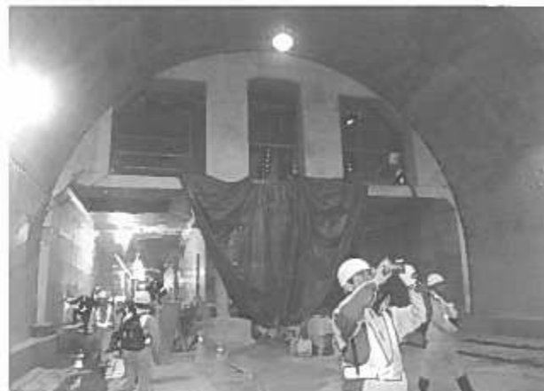
写真6. 八木山トンネル 駅部大断面
