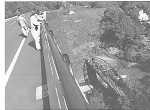
写真 3. 祭時大橋直下の古いトラス橋
