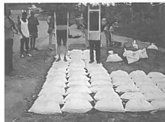
写真 5. 日本の土嚢による道路路盤強化作業
