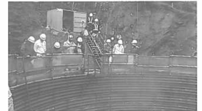
写真 4. P2 橋脚の現場
