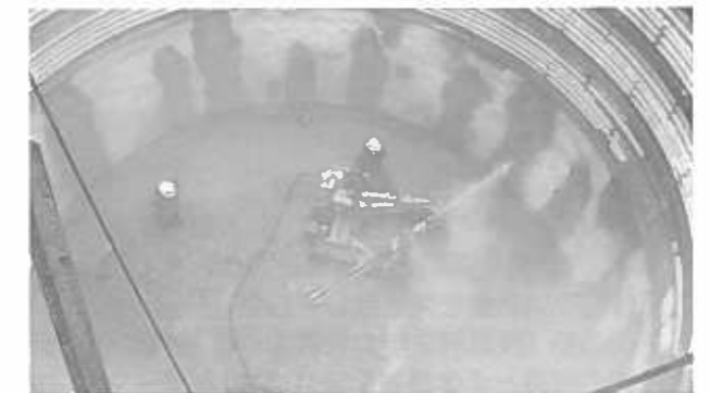
写真 5. 深度 10m 地点での作業状況
