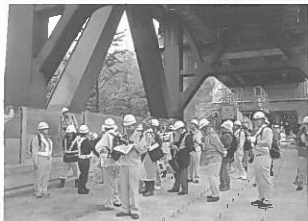
写真4. 竜の口橋梁 鉄道部床版
