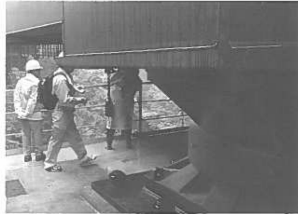
写真5. 竜の口橋梁 鋼製支承
