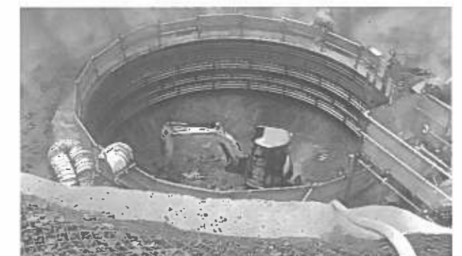
写真 6. P1 深礎掘削機械
