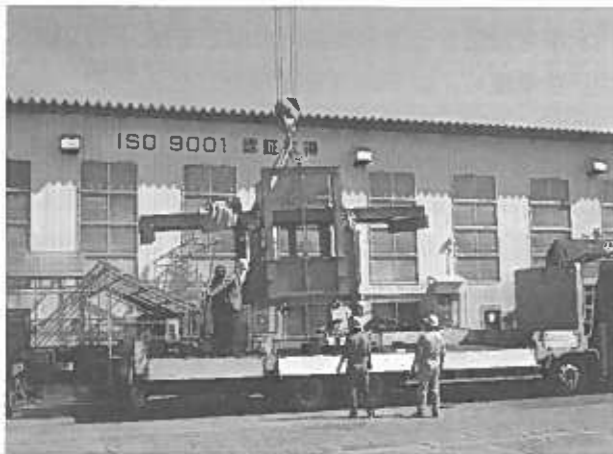
写真 2. 架台搬出状況
