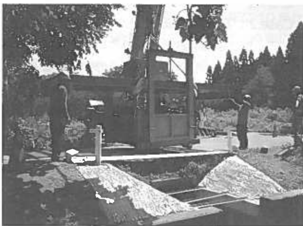
写真 3. 架台設置状況
