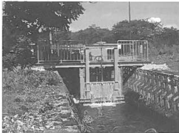
写真 4. 完全吊り下げ型架台全景
