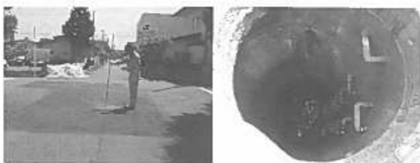
写真 5. 流量観測箇所およびマンホール内部
