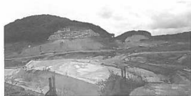
写真2. 藤沼湖工事状況(手前は本堤、奥が副堤)
