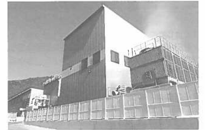
写真4. 木質バイオマス発電所の外観
