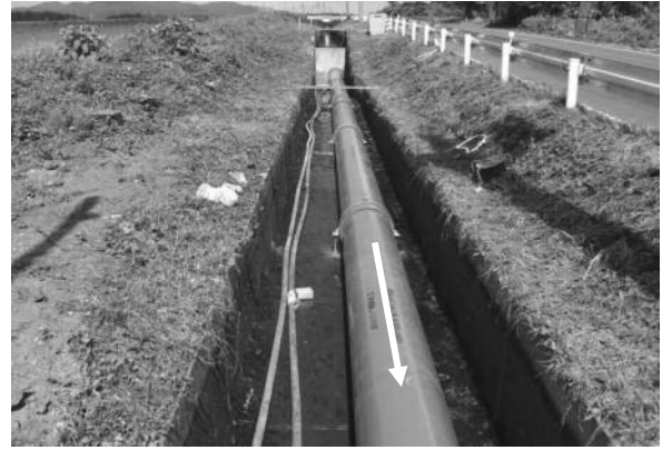
写真1. 既設水路への導水管の設置
