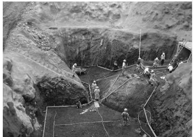
写真 2. 接地工事の様子
