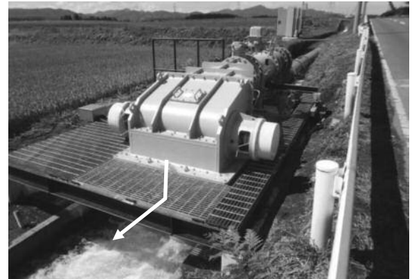
写真2. 水車発電設備
