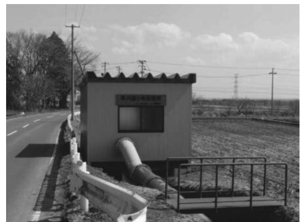
写真 5. 現在の発電設備
