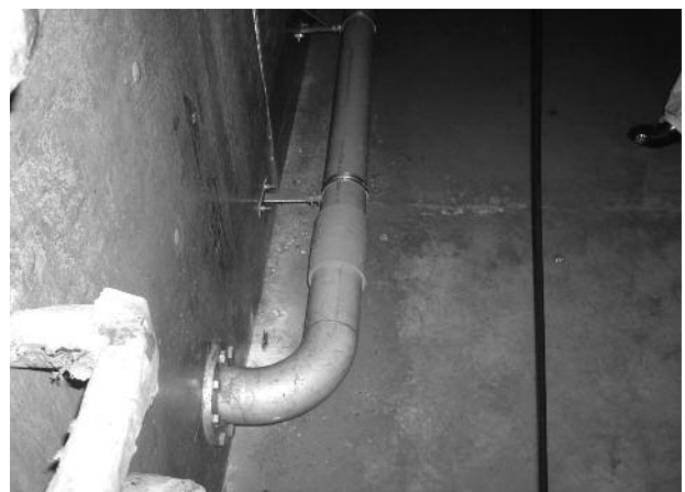
写真 1. 隧道に設置した水位計用連通管
