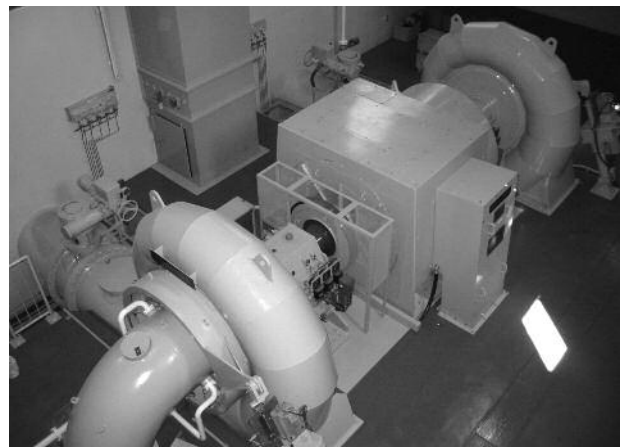
写真5. 両掛二輪水車と発電機
