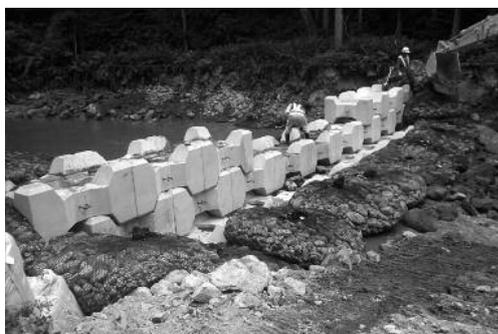
写真 3.1 仮設床固工設置状況 (H26.8.1)
