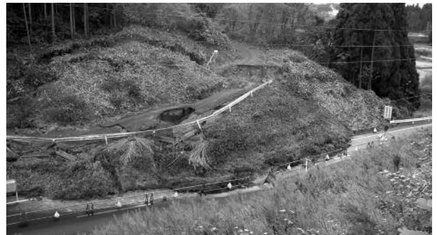
写真 4. 切土後長期間経過し発生した流れ盤すべり
