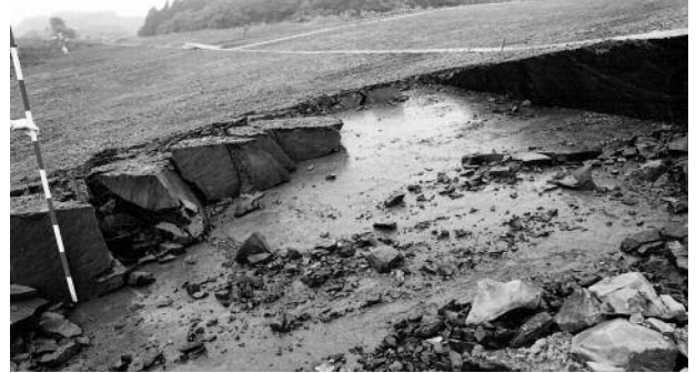
写真 3. 堆積軟岩の切土中に発生した流れ盤すべり
