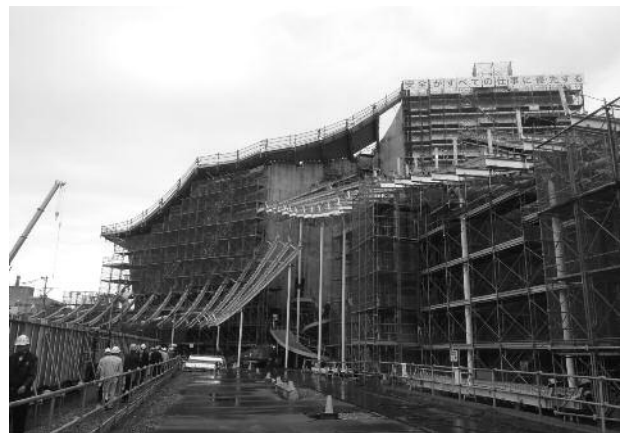
写真 3. 建設中の鶴岡市文化会館
