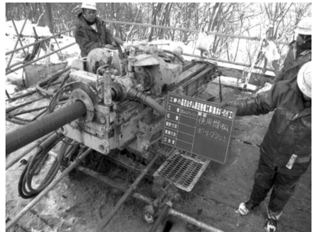
写真 1. 一般的な集水ボーリングの機械
