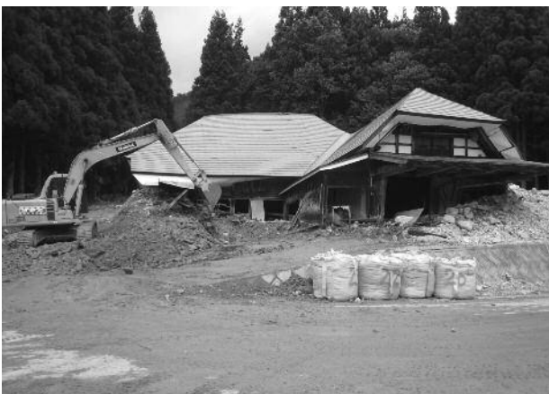
写真 2. 人家①の被害状況及び土砂流出状況
