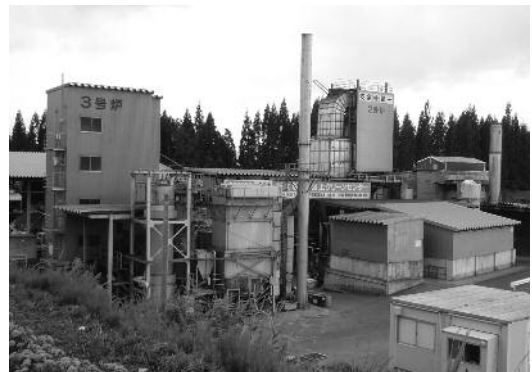
写真 2. アスベスト無害化処理システム
