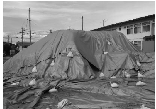
写真 1. 雪山簡便冷房システム
