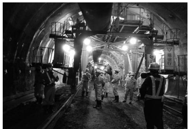
写真 4. トンネル現場の研修状況
