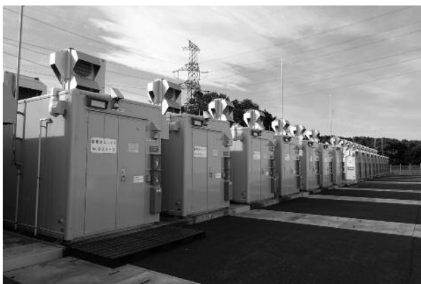
写真 3. 西仙台変電所蓄電池コンテナ
