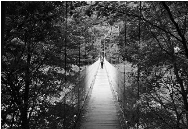
写真 1. 野呂川に架かる吊り橋
