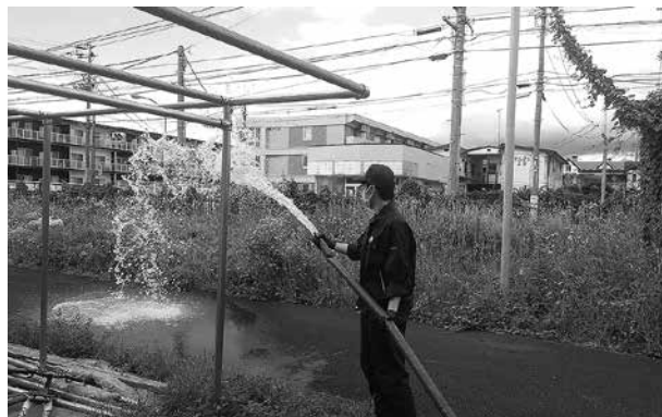
写真3. 組立後の動作確認（ポンプの組立）
