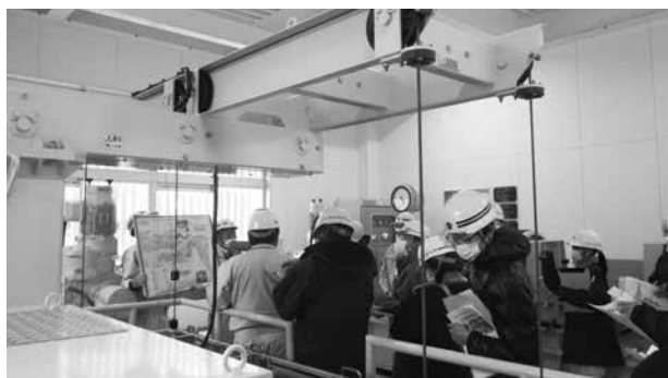
写真4. 完成した取水塔上屋内操作室
