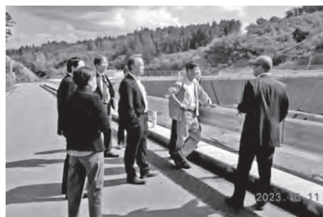
写真5. 鶴岡市一般廃棄物最終処分場
