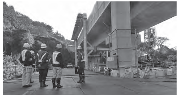
写真 4. 工事現場全景
